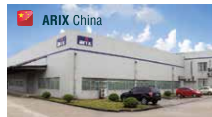
ARIX China Produzione e Distribuzione Cina Manufacturing & Distribution in China Total Area: 3.360 mq - Buildings: 1.700 mq
